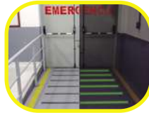
BANDA LUMINISCENTE DE 10MM QUE SE RECARGA CON LA EXPOSICIÓN A LA LUZ
